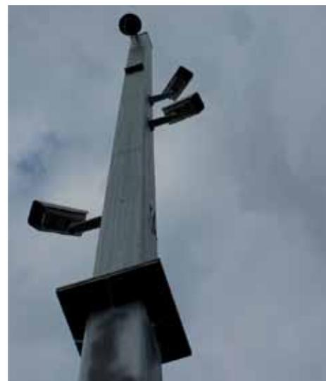
FLIR FCシリーズSは中央の柱から異なるエリアを監視し、アラームが発生すると、中央にある高速ドーム型カメラが作動して、犯人を識別することができます。
