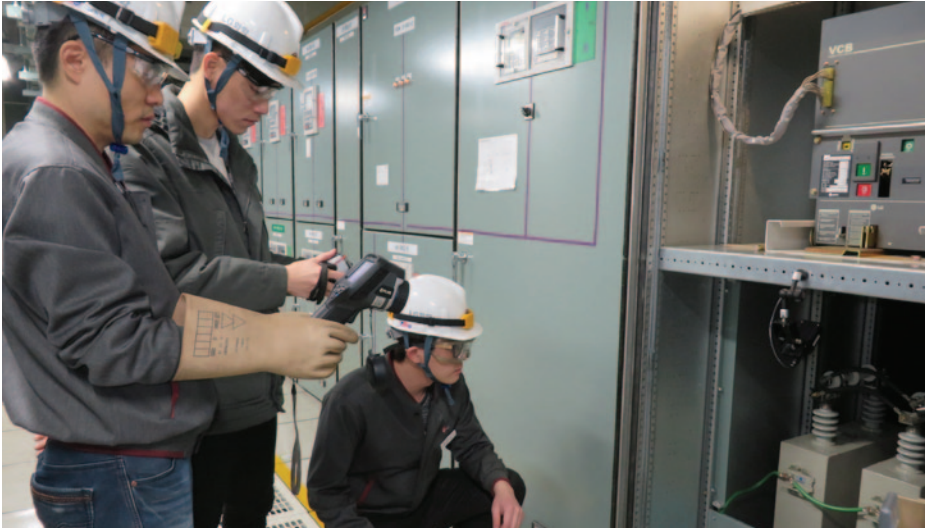
LG化学梧倉第一工場でのフリーアースシステムズの赤外線サーモグラフィを用いた診断・監視（主任 Hong Chang-hwan氏、Lee Dong-Hyun氏、職員Park Chang-wan氏）
